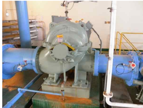
흡입, 토출관 무선 센서 설치
