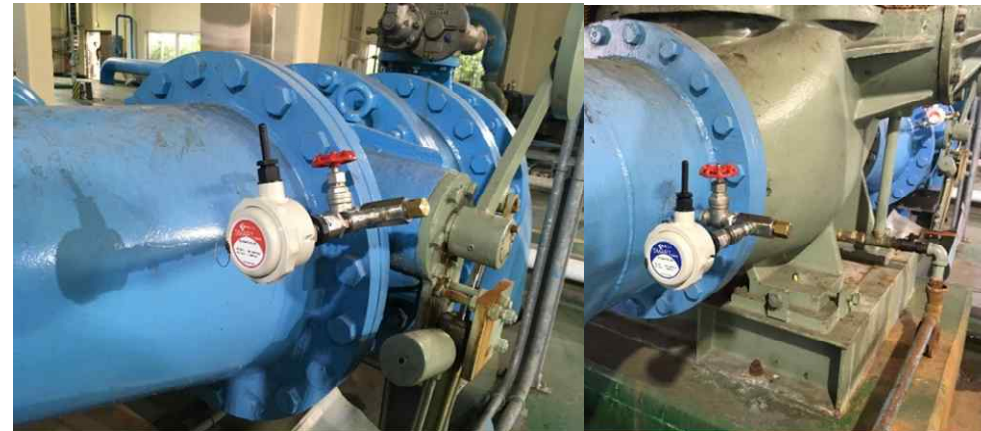
흡입, 토출관 무선 압력 센서 설치
